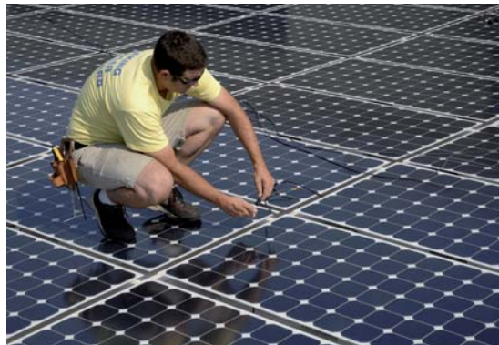
Montage von Photovoltaikmodulen.
