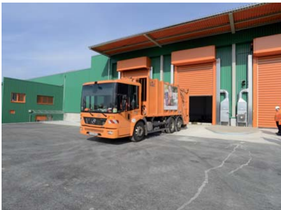
Biogasanlage der BSR
